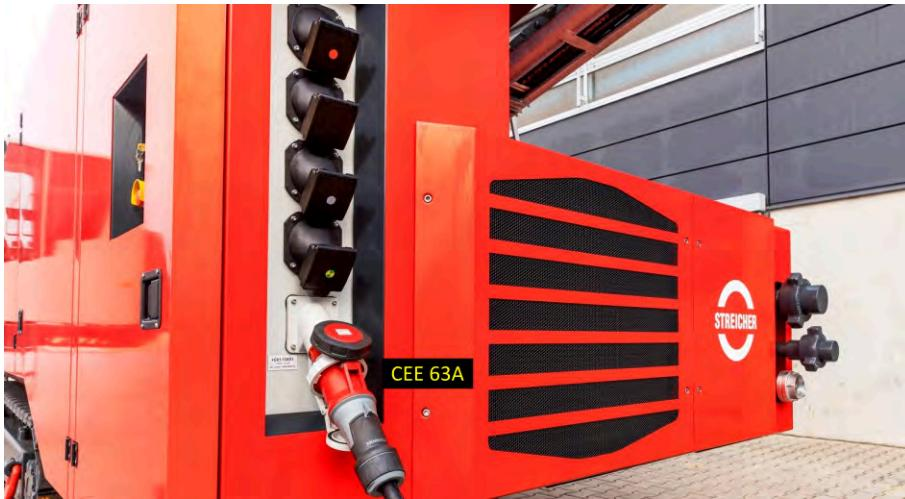
Abb. 7-7: Hilfsversorgung Netzbetrieb
