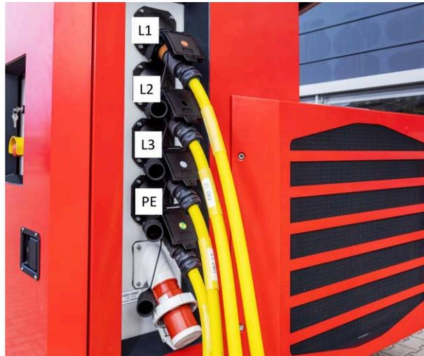
Abb.7-5: Versorgung Netzbetrieb
