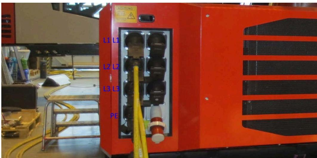
Abb. 7-5: Versorgung Netzbetrieb
