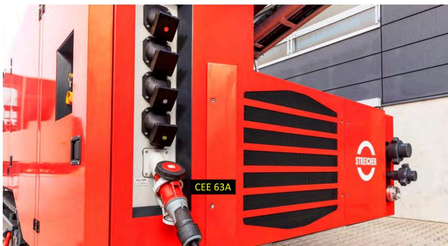
Abb. 7-7: Hilfsversorgung Netzbetrieb
