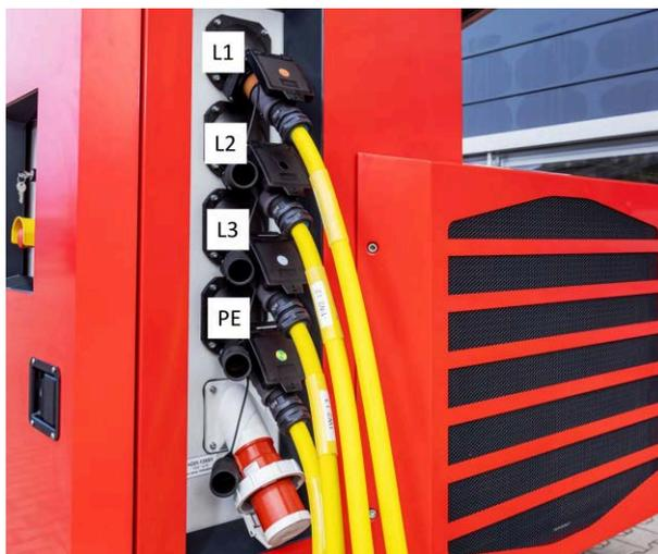
Abb. 7-5: Versorgung Netzbetrieb
